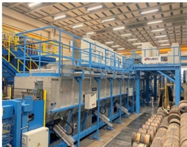
Die neue Anlage wurde nahtlos in den bestehenden Hallenaufbau eingefügt.
