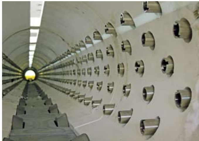
Die Leistung der einzelnen Brenner ist bewusst vergleichsweise klein gehalten, dafür setzt extrutec mehr Brenner als andere Ausrüster ein
